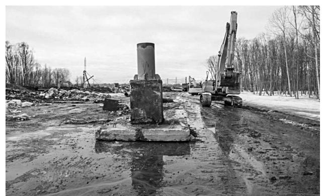
Рис. 14. Демонтированная эстакадная опора ВПМГ на столбчатом фундаменте, извлечённая из-подо льда (наледи) в западной части долины р. Авачи
