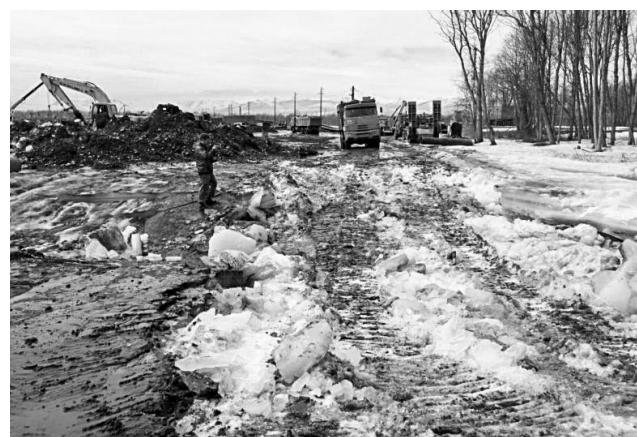
Рис. 16. Принудительно разрушенная экскаватором ледовая переправа через русло второстепенной пойменной протоки в западной части долины р. Авачи. Дальнейшие переезды техники через протоку осуществлялись вброд (фото 27.04.2012 г.)
