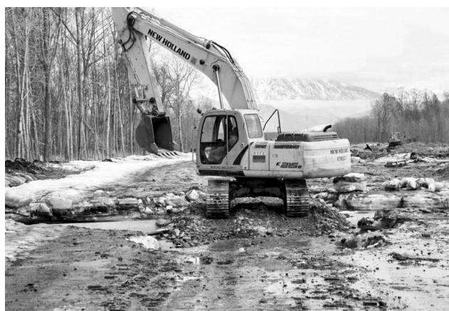
Рис. 15. Переезд вброд через русло второстепенной протоки в западной части долины р. Авачи с размещением в русле насыпей грунта и обрезков демонтированного трубопровода ВПМГ (фото 27.04.2012 г.)
