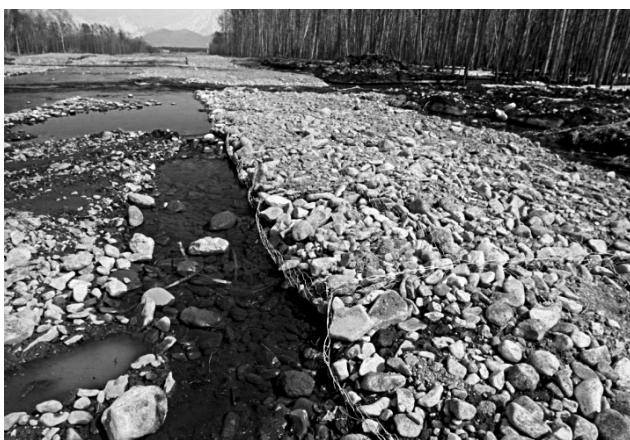
Рис. 19. Габионы в створе основной нитки. В результате нарушения естественного продольного профиля двух правобережных второстепенных проток и плавновысотных отметок прилежащих участков поймы после реконструкции перехода МГ образовались искусственные гидрологические ловушки для молоди лососей, в которых после снижения уровня воды в реке происходила их гибель (фото 16.05.2012 г., начало весенне-летнего половодья)
