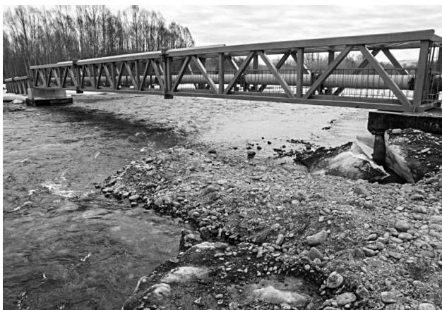
Рис. 9. Наполовину демонтированная ферма (балка) ВПМГ и валик обратной засыпки траншеи основной нитки ППМГ через главную пойменную протоку р. Авачи в центральной части долины
