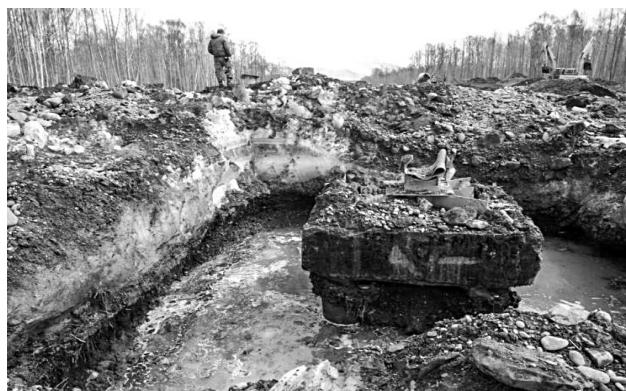
Рис. 13. Котлован вокруг эстакадной опоры ВПМГ на свайном фундаменте перед её демонтажем (западная часть долины р. Авачи). По периметру котлована – наледь высотой 2 м, в которую к концу зимы вмёрз трубопровод ВПМГ (фото 27.04.2012 г.)
