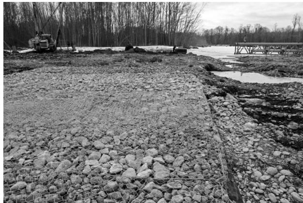
Рис. 11. Габионы, размещённые на льду (в русле) второстепенной пойменной протоки р. Авачи в центральной части долины в створе перехода 2 ниток ППМГ. На заднем плане – демонтированные конструкции ВПМГ основной нитки
