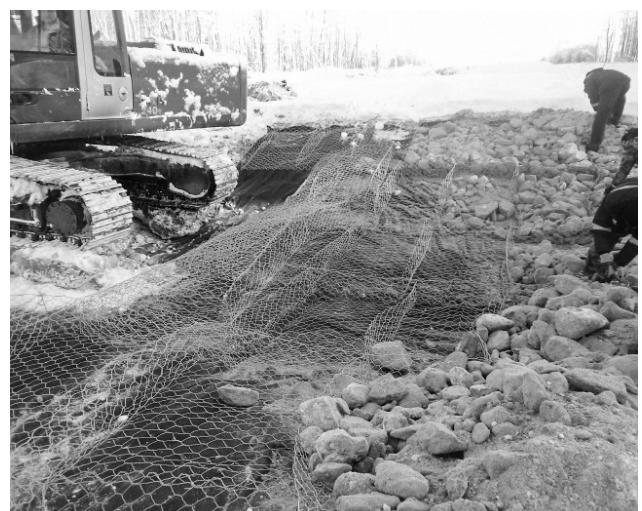
Рис. 22. Повторная укладка габионов, декабрь 2012 г.
