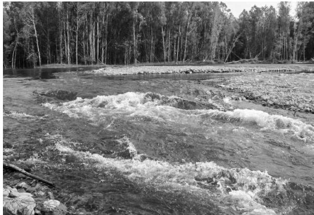
Рис. 25. Быстроток – направленный габионами сброс воды с участка русла, укреплённого габионами, ниже створа ППМГ активизирует регрессивную эрозию (фото 20.06.2012 г.)
