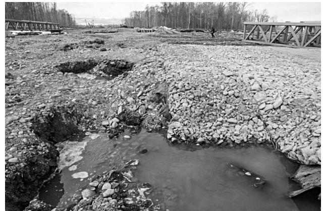
Рис. 12. Габионы, размещённые на льду протоки р. Авачи в центральной части долины (с частичным провалом в русло после распавления льда) в створе ППМГ. На заднем плане – демонтированные конструкции ВПМГ
