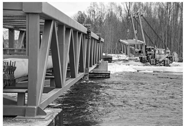
Рис. 10. Демонтаж конструкций фермы (балки) ВПМГ через главную и второстепенную протоки р. Авачи в центральной части долины
