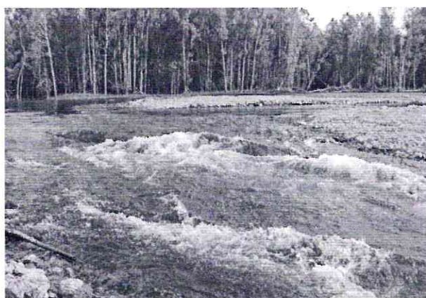
Рис. 25. Быстроток – направленный габионами сброс воды с участка русла, укрепленного габионами, ниже створа ППМГ активизирует регрессивную эрозию (фото 20.06.2012 г.)
