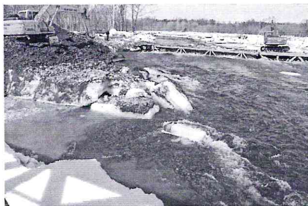
Рис. 7. Засыпка траншеи основной нитки ППМГ на правом берегу главной протоки (центральная часть долины) (фото 18.04.2012 г.)
