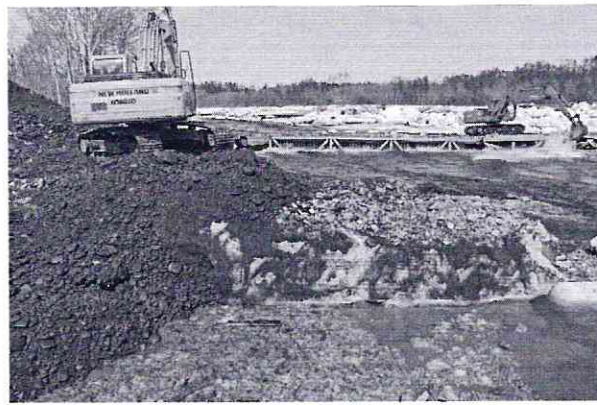
Рис. 8. Засыпка траншеи основной нитки ППМГ (передний план слева) и перемещение льда через временный мост (задний план справа) (фото 18.04.2012 г.)
