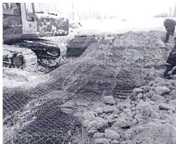
Рис. 22. Повторная укладка габионов, декабрь 2012 г.
