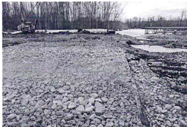
Рис. 11. Габионы, размещённые на льду (в русле) второстепенной пойменной протоки р. Авачи в центральной части долины в створе перехода 2 ниток ППМГ. На заднем плане – демонтированные конструкции ВПМГ основной нитки (фото 27.04.2012 г.)
