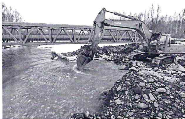
Рис. 3. Разработка траншеи из-под воды экскаватором, оснащённым скальным ковшом, в русле второстепенной пойменной протоки р. Авачи (в восточной части долины) рядом с действующей (пока ещё не демонтированной) основной ниткой ВПМГ (фото 12.04.2012 г.)
