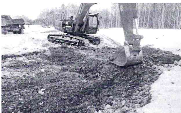
Рис. 21. Демонтаж ранее уложенных габионов в руслах второстепенных пойменных проток р. Авачи по иску природоохранного прокурора (фото декабрь 2012 г.). Экскаватор разравнивает грунт валика обратной засыпки для последующей вторичной укладки габионов над ним
