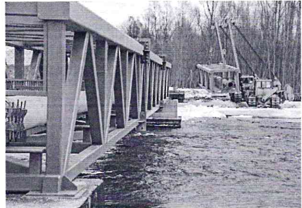
Рис. 10. Демонтаж конструкций фермы (балки) ВПМГ через главную и второстепенную протоки р. Авачи в центральной части долины (фото 27.04.2012 г.)
