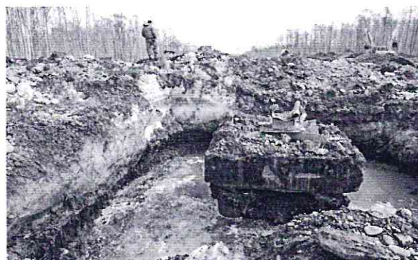
Рис. 13. Котлован вокруг эстакадной опоры ВПМГ на свайном фундаменте перед её демонтажом (западная часть долины р. Авачи). По периметру котлована – наледь высотой 2 м, в которую к концу зимы вмёрз трубопровод ВПМГ (фото 27.04.2012 г.)
