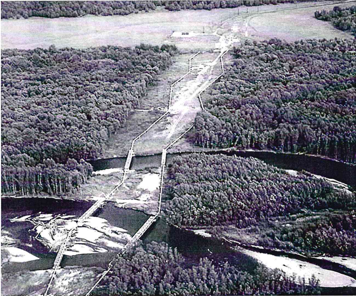
Рис. 1. ВПМГ через долину р. Авачи. На переднем плане – центральные протоки с балочными переходами ВПМГ (фото О. А. Чернягиной, июль 2010 г.)
