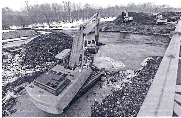
Рис. 4. Разработка траншеи основной нитки МГ из-под воды экскаватором, оборудованным скальным ковшом, в русле основной левобережной пойменной протоки р. Авачи (восточная часть долины; справа на снимке – балка (ферма) действующего (пока ещё не демонтированного) перехода основной нитки ВПМГ (фото 12.04.2012 г.)
