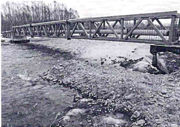
Рис. 9. Наполовину демонтированная ферма (балка) ВПМГ и валик обратной засыпки траншеи основной нитки ППМГ через главную пойменную протоку р. Авачи в центральной части долины (фото 27.04.2012 г.)
