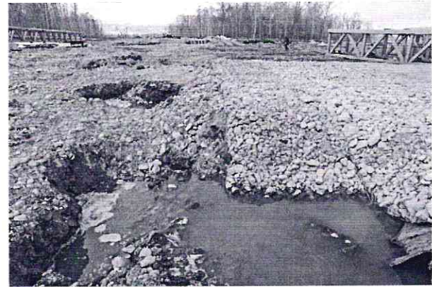
Рис. 12. Габионы, размещённые на льду протоки р. Авачи в центральной части долины (с частичным провалом в русло после распадаения льда) в створе ППМГ. На заднем плане – демонтированные конструкции ВПМГ (фото 27.04.2012 г.)
