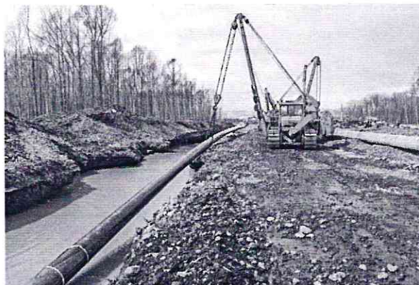
Рис. 6. Пойменная (между протоками) часть траншеи в западной части долины р. Авачи с подвешенным трубопроводом основной нитки ППМГ (фото 27.04.2012 г.)
