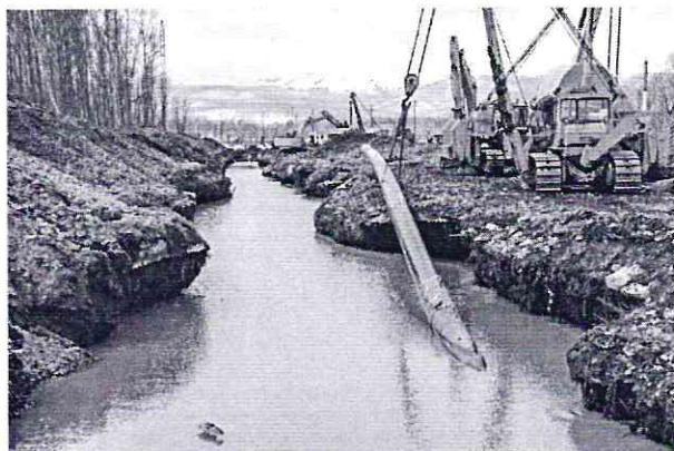
Рис. 5. Пойменная (между протоками) часть траншеи в западной части долины р. Авачи с подвешенным трубопроводом основной нитки ППМГ (фото 27.04.2012 г.)
