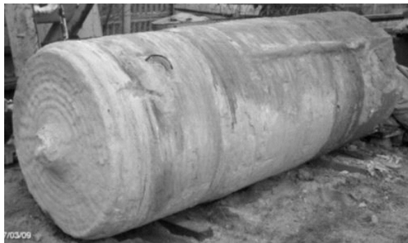
Рис. 3. Внешний вид откопанной грунтоцементной колонны
