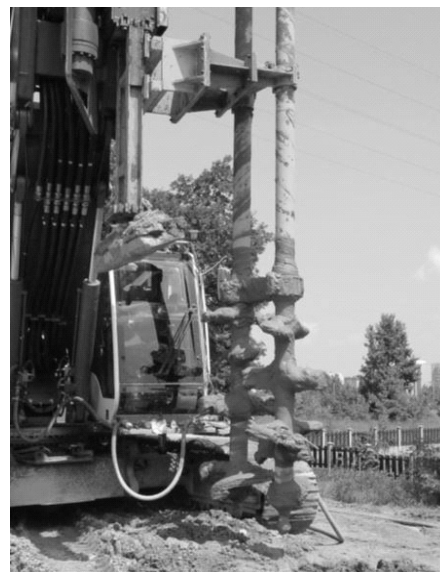
Рис. 2. Общий вид установки при устройстве колонн DSM
