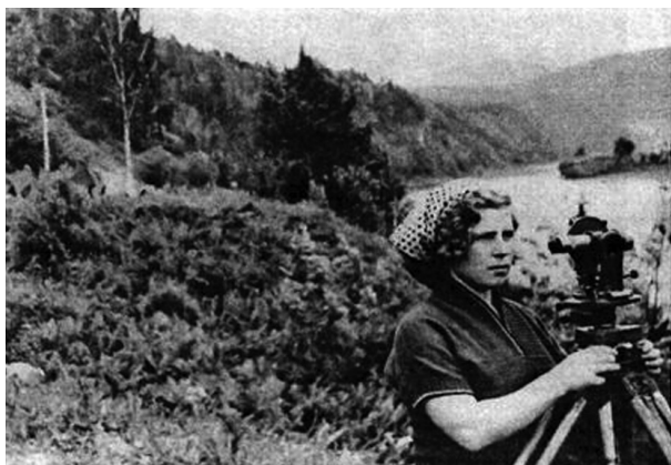
Раиса Бородина, 1956 г. Створ будущей плотины Красноярской ГЭС
